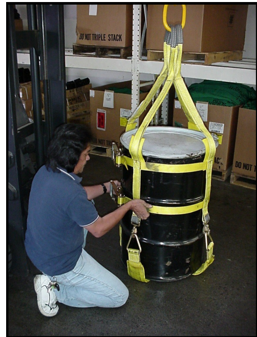
Step 4: Levante la carga lo suficiente para que esté por encima del suelo. Si es necesario baje y reajuste las bandas. Repita esta operación cuantas veces sea necesario hasta que se alcancen el balance y el control deseados.
